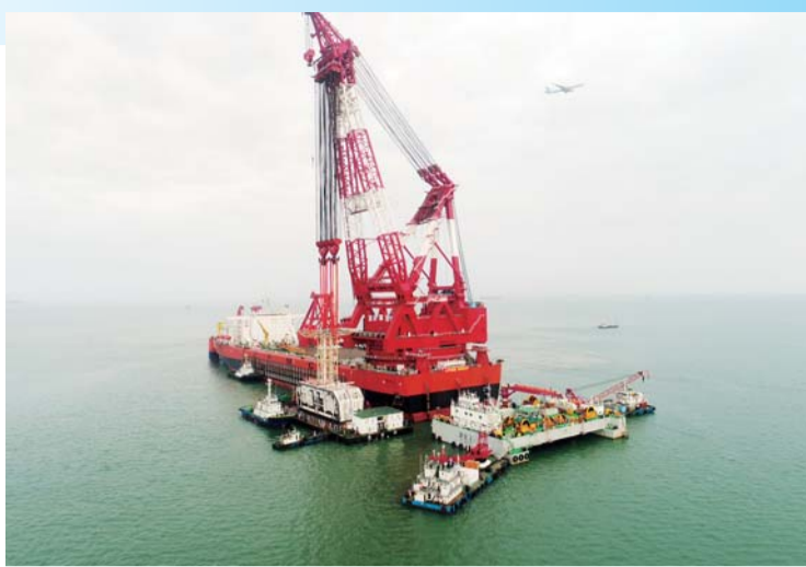
港珠澳大桥岛隧工程最终接头安装成功
