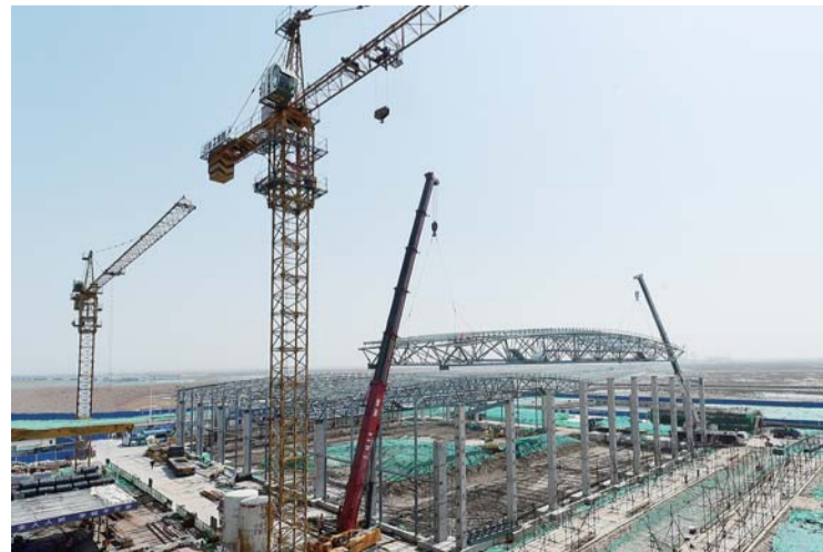
4月16日，四公司承建的天津临港科研发验基地项目土方试验大厅工程大跨度钢桁架吊装全部完成。周博 王海 摄影报道
