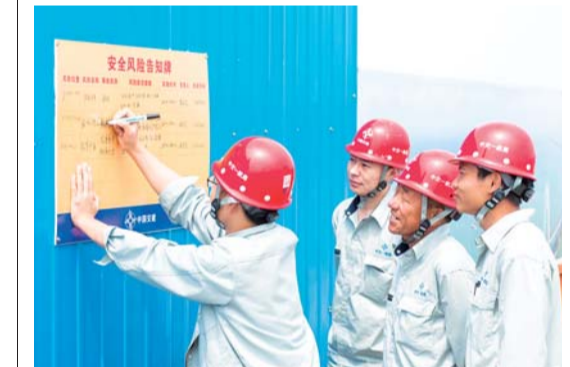
汕头综合管廊项目把预防为主的方针落实到事前的风险辨识、评价和防范上。图为安全员认真填写安全风险告知牌，对施工过程中辨识的重要风险进行公示。程宇 摄影报道
