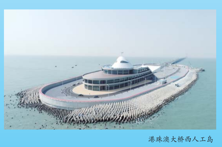
港珠澳大桥西人工岛
